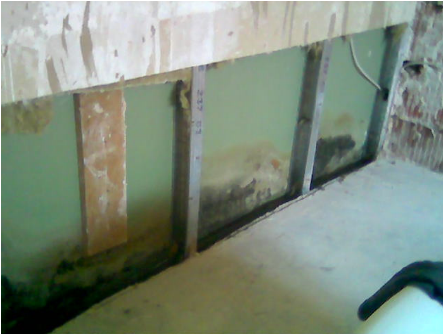
Gipskartonwand mit Mineralwolldämmung nach dem Öffnen.
