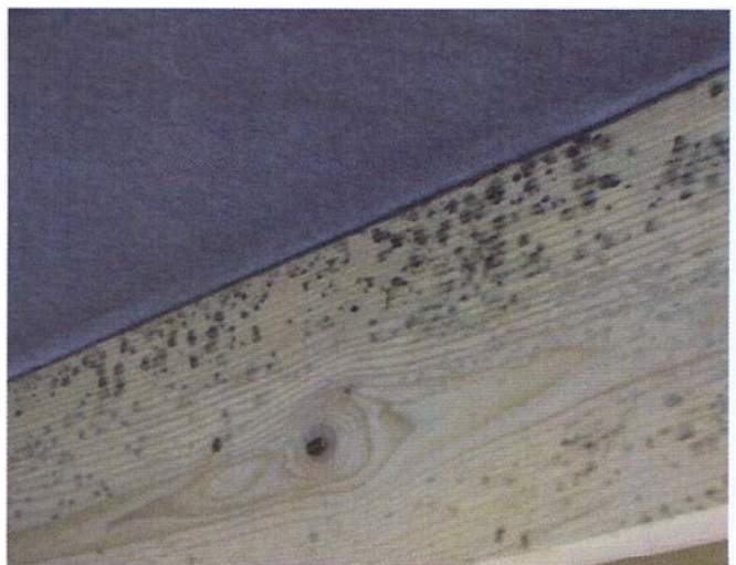
Abb.4: Schimmel auf Dachsparren (Bild: © Josef Reis)
