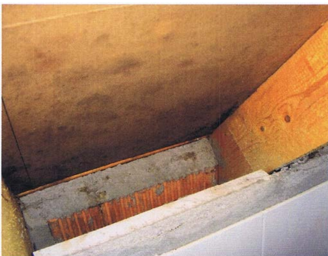
Abb. 1: zeigt den Befall von Dematiaceae (Schwärzepilze) auf Holzfaserdämmplatten (Bild: © Josef Reis)
