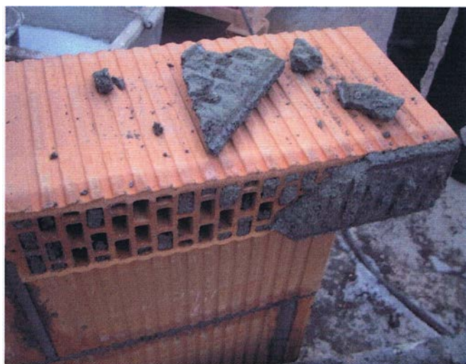
Abb. 5: zeigt den an den Mauerstein gefrorenen Mörtel (Bild: © Josef Reis)
