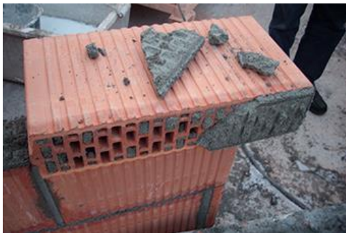
GTÜ Winterbaustelle: gefrorenes Mauerwerk und Mörtel (Foto: Josef Reis)
