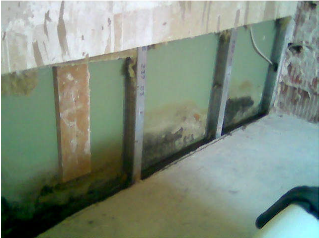
Gipskartonwand mit Mineralwolldämmung nach dem Öffnen.
