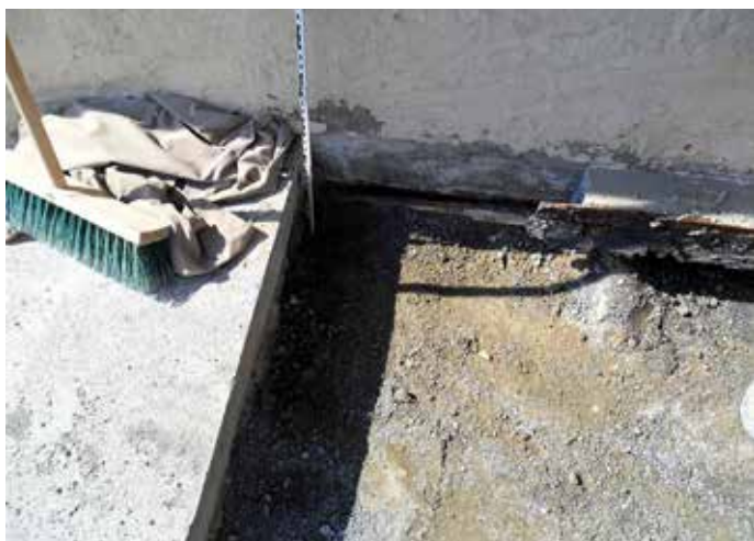
Abb. 8+9: Erst nach dem Öffnen des Pflasters wurde klar, dass die Wandabdichtung viel zu niedrig angebracht worden war und an der Befestigungsschiene keine Versiegelung aufwies.
