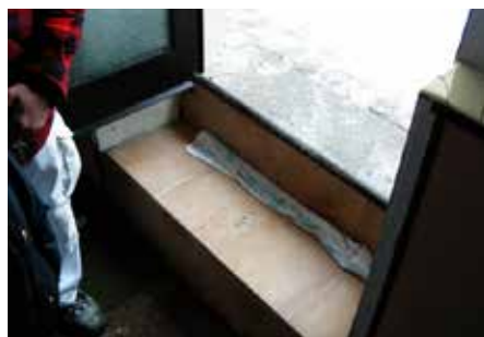
Abb. 3: Früher hatte der rückwärtige Eingang in das zweite Obergeschoss des Gasthauses vom Kirchplatz aus eine Stufe. Seit der Sanierung ist er ebenerdig und bei Tauwetter läuft das Tauwasser ins Haus.
