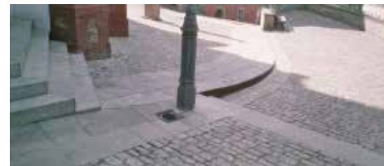
Abb. 4: Kirchentreppe mit Rollstuhlrampe und Straßenablauf
