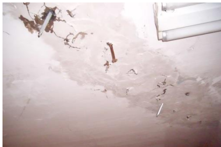
(10) Geschlossener und verpresster Deckenriss (Bild: © Josef Reis)
