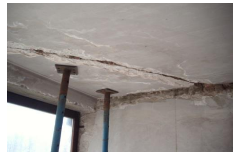
(4) Abriss einer Deckenecke (Bild: © Josef Reis)
