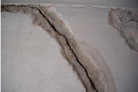
(6) Freigelegter Wandriss mit abzweigendem Deckenriss (Bild: © Josef Reis)
