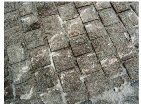
Abb. 9: Gesägtes Natursteinpflaster mit 2 cm breiten Pflasterfugen
