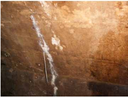
Abb. 4 zeigt die gleiche Stelle des Kellergewölbes wie Abb. 3, jedoch etwa 18 Monate später. Die Länge des Stalaktiten beträgt nun etwa 22 cm.
