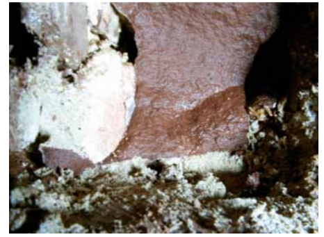
Abb. 6 ist eine Vergrößerung aus Bild 5. Hier kann man gut den weißen Niederschlag des aus dem Mörtel gelösten Kalkes erkennen.
